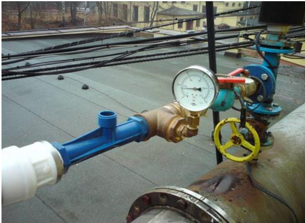
Obr. 2. Experimentální poloprovozní aplikace injektoru na ÚV Ostrava-Nová Ves
